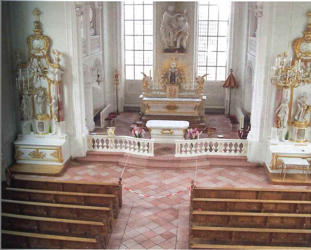
Die Reinigung des Natursteinbodens von St. Johann in Saarbrücken kann heute dank NP-Flüssigglass mit Wasser erfolgen; früher waren Schmutz und Kerzenwachs kaum davon zu lösen.
